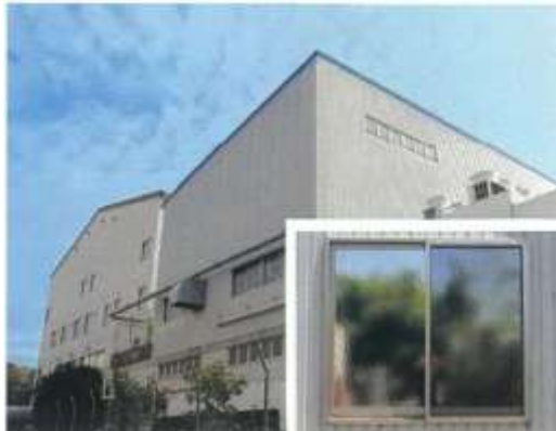
↑ 施工事例(自動車製造工場様)
